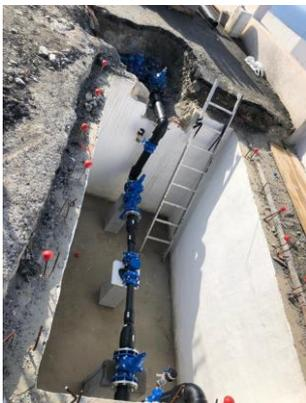
Asimismo, la conexión principal de agua en la Bajada del Mar fue completamente renovada por la empresa Bagelsa. Esto incluyó la construcción de una nueva caja de instalación de acuerdo con la norma establecida por Agua y Servicio, así como la sustitución de todas las válvulas y del contador de agua por Agua y Servicios. Afortunadamente, esto solucionó los problemas de la bajísima presión del agua. No se han recibido más comentarios negativos de los vecinos afectados.
